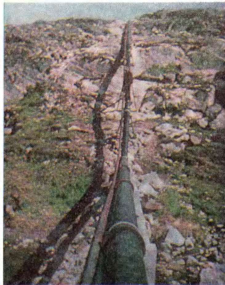
Водопровод среди скал
